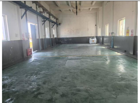
铝灰暂存间（内）
