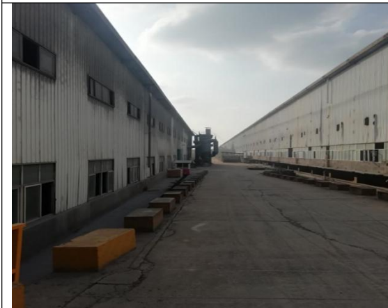
重熔除尘设施
