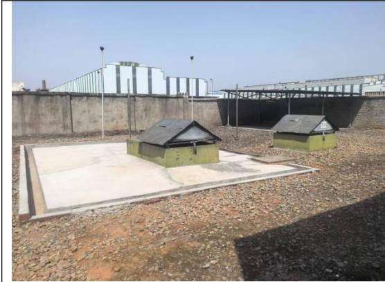
柴油储罐（地埋）
